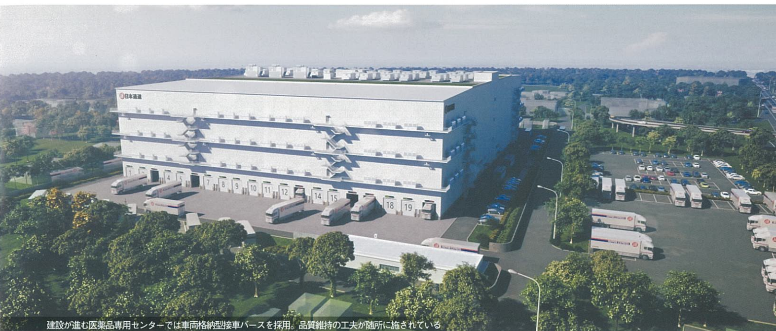
建設が進む医薬品専用センターでは車両格納型接車バスを採用。品質維持の工夫が随所に施されている
